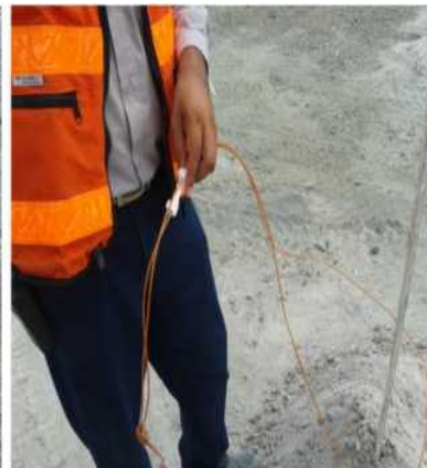
FIGURA 6 - INSTALAÇÃO DO EXPLOSIVO CONCLUÍDA
