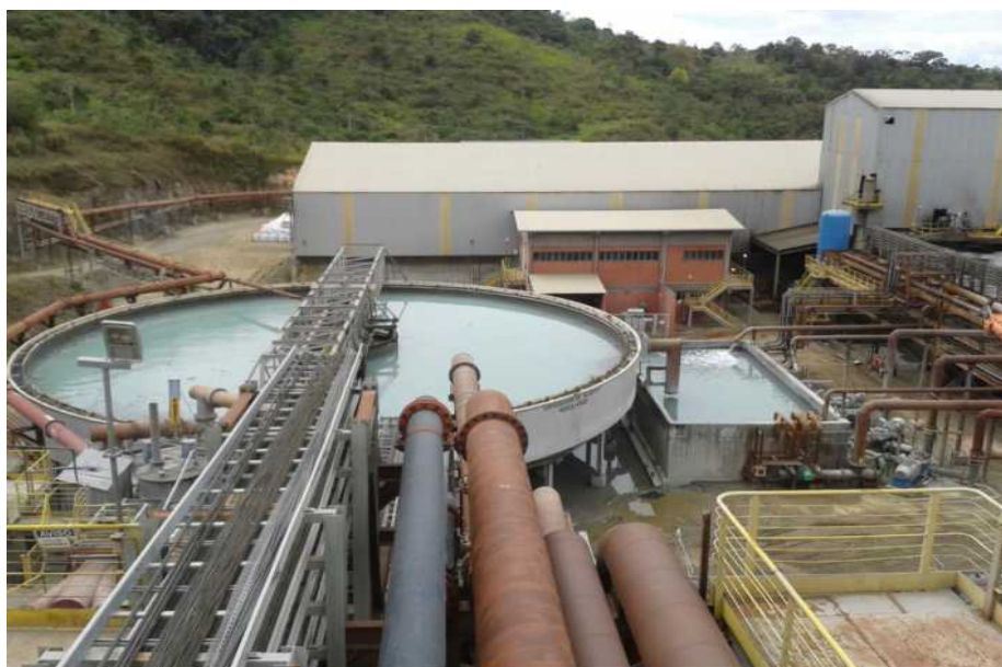
FIGURA 18 - ESPESSADOR DE REJEITOS
