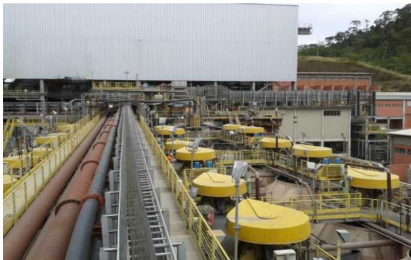
Figura 17 - Células de Flotação
